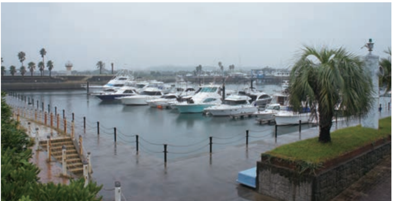
▲マリーナ河芸のマリーナ(係留・保管施設)全景
