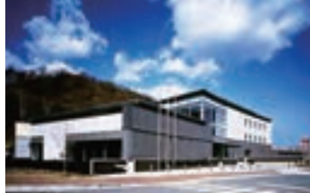
福島県水難救済会事務局が入居する「福島県水産会館」
