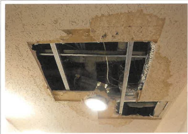
No. 1 3階男子便所手洗い 天井 施工前
