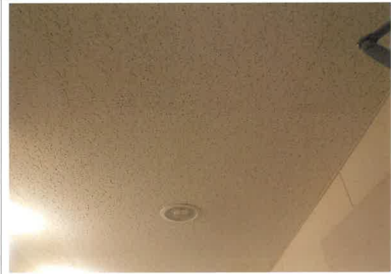
No. 2 3階男子便所手洗い 天井貼替完了
