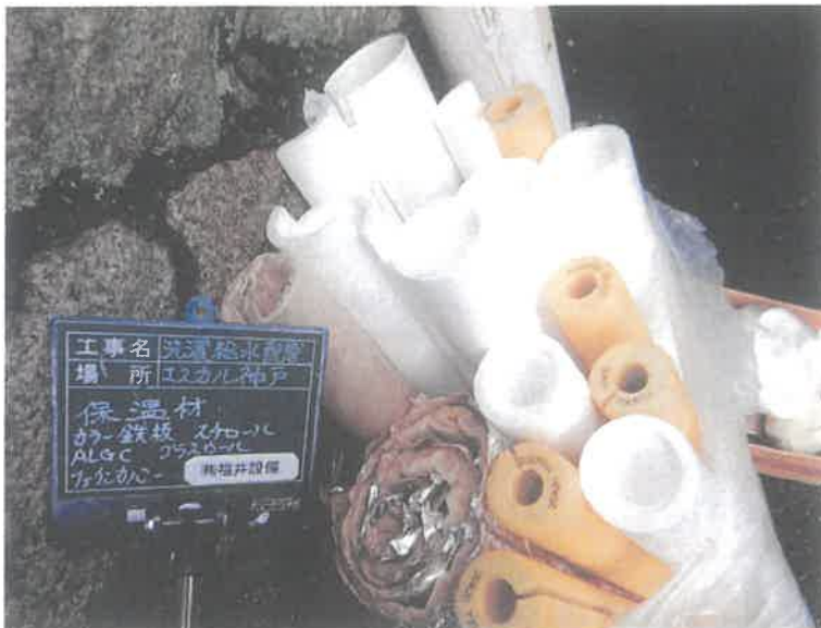
【工事種目】エスカル神戸洗濯給水配管 【施工内容1】5階洗濯室 【施工内容2】保温巻き工事 【施工内容3】保温材
