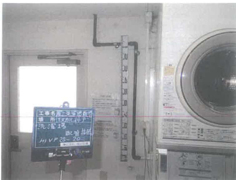
【工事種目】エスカル神戸洗濯給水配管 【施工内容1】5階洗濯室 【施工内容2】配管作業HIVP20A 【施工内容3】支持金具取付 【施工内容4】切替接続
