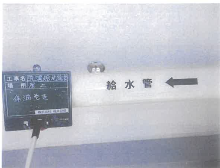
【工事種目】エスカル神戸洗濯給水配管 【施工内容1】5階洗濯室 【施工内容2】屋上外部 【施工内容3】ポリスチレンフォーム保温筒/カラー亜鉛鉄板
