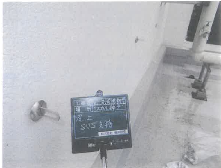
【工事種目】エスカル神戸洗濯給水配管 【施工内容1】屋上外部 【施工内容2】支持金具取付
