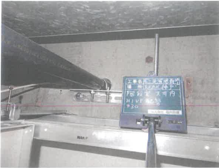
【工事種目】エスカル神戸洗濯給水配管 【施工内容1】5階廊下天井内 【施工内容2】配管作業HIVP30A 【施工内容3】支持金具取付 振れ留め
