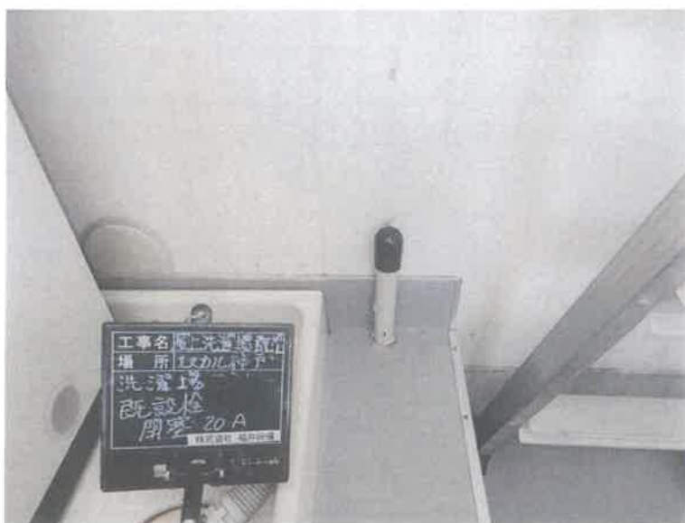
【工事種目】エスカル神戸洗濯給水配管 【施工内容1】5階洗濯室 【施工内容2】既設タンク末流キャップ留め
