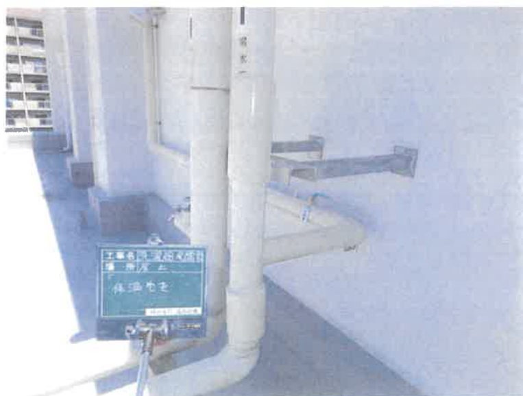
【工事種目】エスカル神戸洗濯給水配管 【施工内容1】5階洗濯室 【施工内容2】屋上外部 【施工内容3】ポリスチレンフォーム保温筒/カラー亜鉛鉄板
