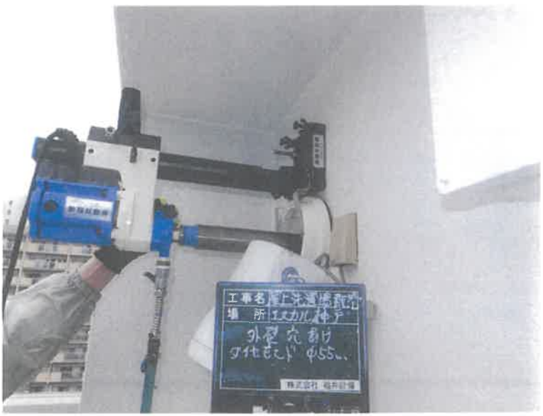
【工事種目】エスカル神戸洗濯給水配管 【施工内容1】屋上外部 【施工内容2】外壁ダイヤモンド貫通
