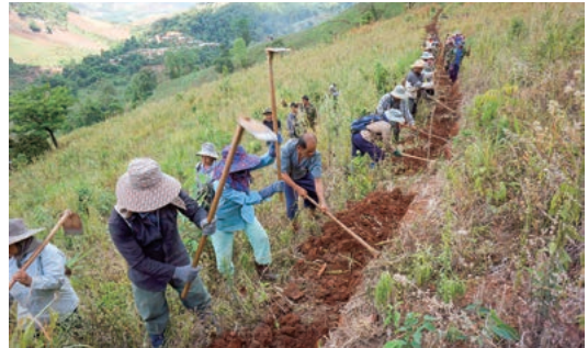
▲みんなで協働（水道配管作業）
