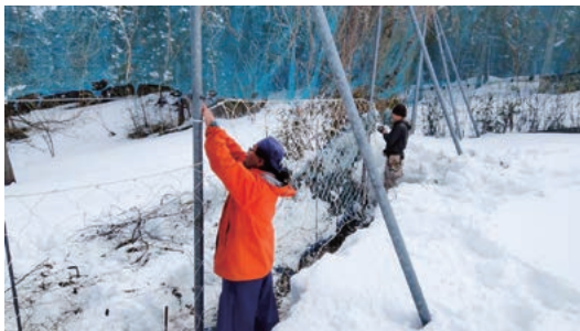
▲雪害による獣害防止柵の補修
