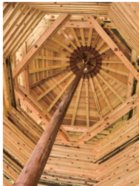
▲「大根」の屋根内部
