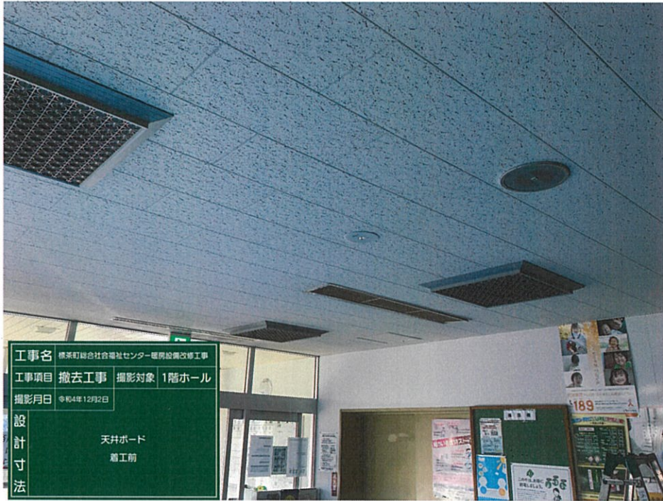
1階ホール 天井ボード
