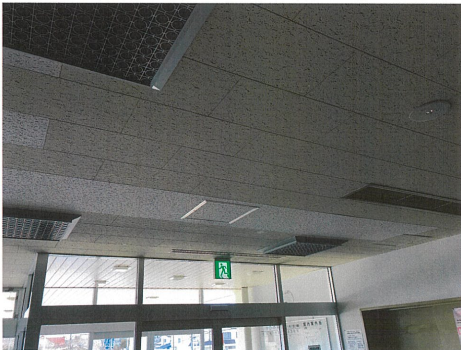
1階ホール 天井ボード
