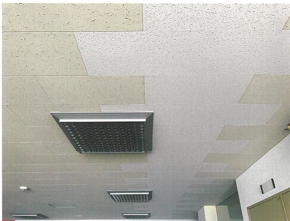
1階ホール 天井ボード
