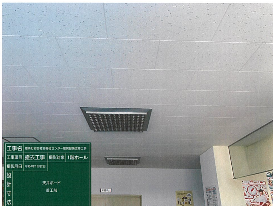
1階ホール 天井ボード
