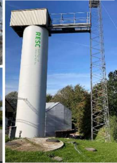
④ 高所作業タワー (300m 2 ) 実際のタワーを利用。 今後、よりリアルとする目的で内部にエレベーターを設置予定。
