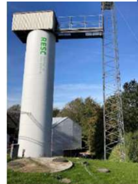
高所作業タワー（RESC） 実際のタワーを利用。 今後、エレベーターを設置予定。
