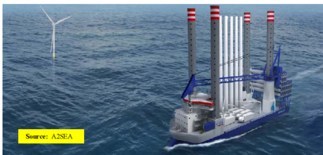
図表 5.14 A2SEA 風車設置作業船
