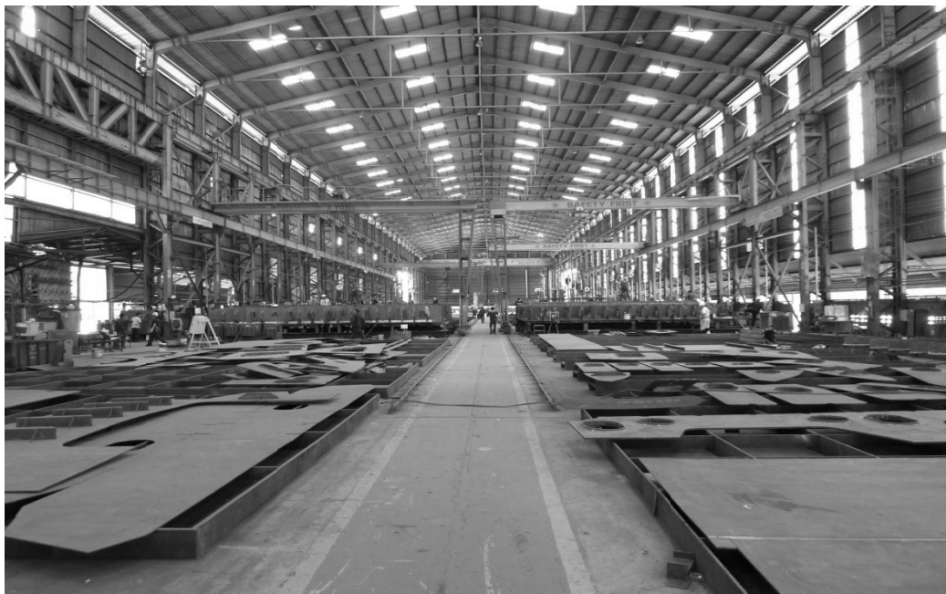
図 16 イタルタイマリン内業工場
