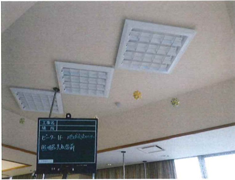
【工事種目】竣工前後 【施工内容1】ピーター1F 地域交流センター 【施工内容2】照明器具取替前
