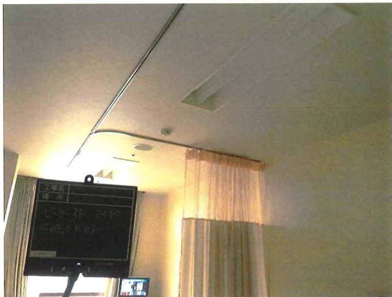
【工事種目】竣工前後 【施工内容1】ビター3F 居室306 【施工内容2】照明器具取替前
