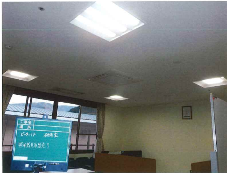
【工事種目】竣工前後 【施工内容1】ピーター1F 研修室 【施工内容2】照明器具取替完了
