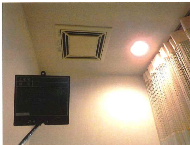
【工事種目】竣工前後 【施工内容1】ピーター3F 居室302 【施工内容2】照明器具取替前
