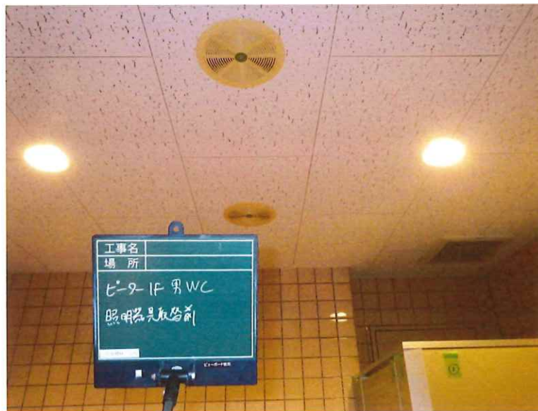
【工事種目】竣工前後 【施工内容1】ピーター1F 男子WC 【施工内容2】照明器具取替前
