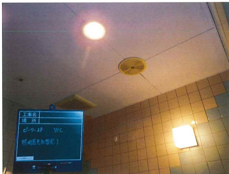
【工事種目】竣工前後 【施工内容1】ピーター-2F WC 【施工内容2】照明器具取替完了
