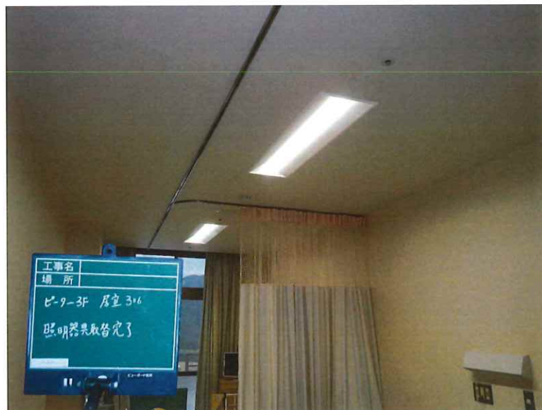
【工事種目】竣工前後 【施工内容1】ビター3F 居室306 【施工内容2】照明器具取替完了
