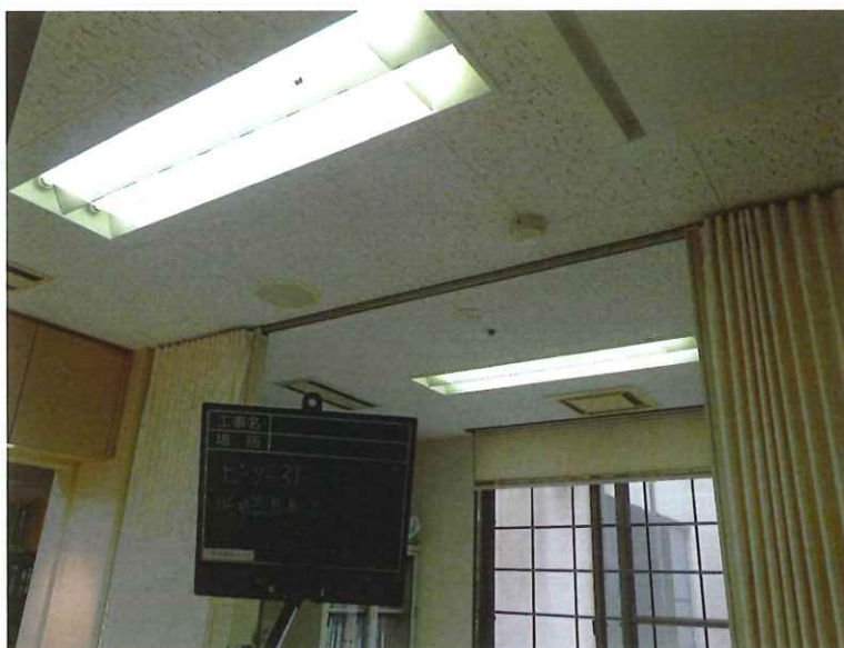
【工事種目】竣工前後 【施工内容1】ピーター3F ステーション 【施工内容2】照明器具取替前
