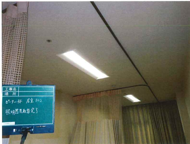
【工事種目】竣工前後 【施工内容1】ピーター3F 居室302 【施工内容2】照明器具取替完了
