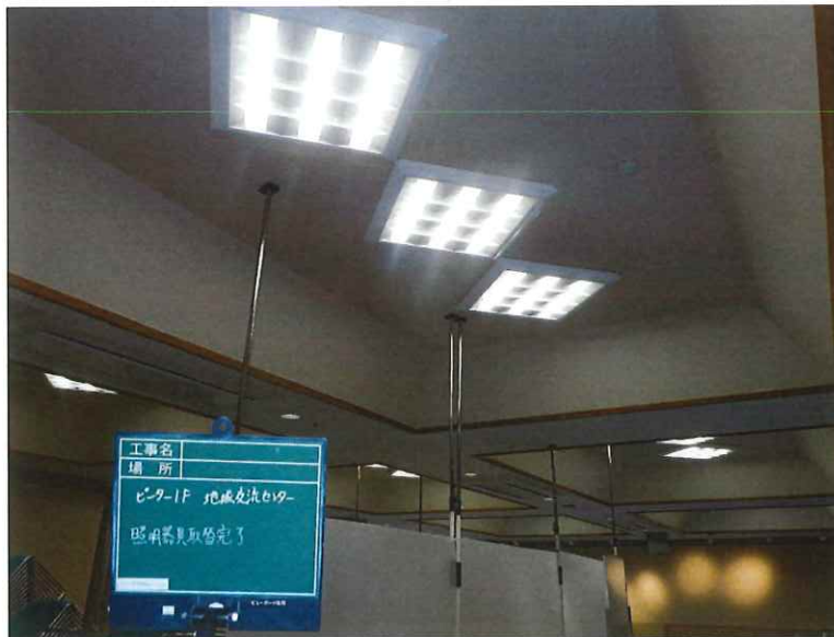
【工事種目】竣工前後 【施工内容1】ピーター1F 地域交流センター 【施工内容2】照明器具取替完了
