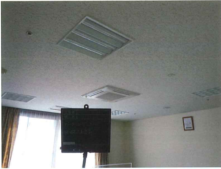
【工事種目】竣工前後 【施工内容1】ピーター1F 研修室 【施工内容2】照明器具取替前
