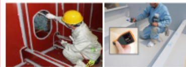
手作業による刷毛塗り（左）と塗膜厚の計測（右）
