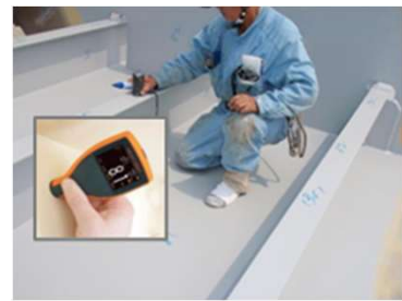
電磁膜厚計による膜厚計測の様子
