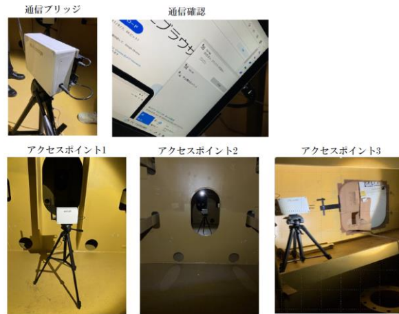
図 4.5 データ無線通信機器の検証の様子（メカトラックス提供）
