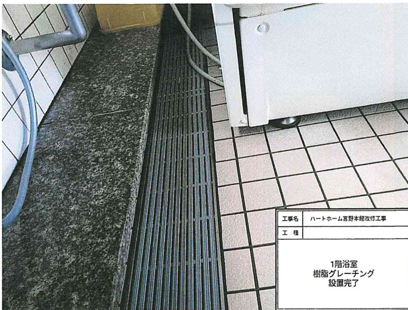
工事名 ハートホーム宮野本館改修工事 工種 1階浴室 樹脂グレーチング 設置完了
