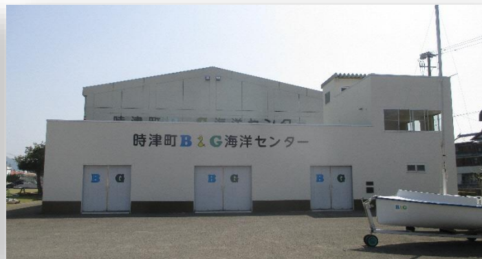
艇庫外壁改修後
