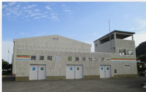
艇庫外壁改修前
