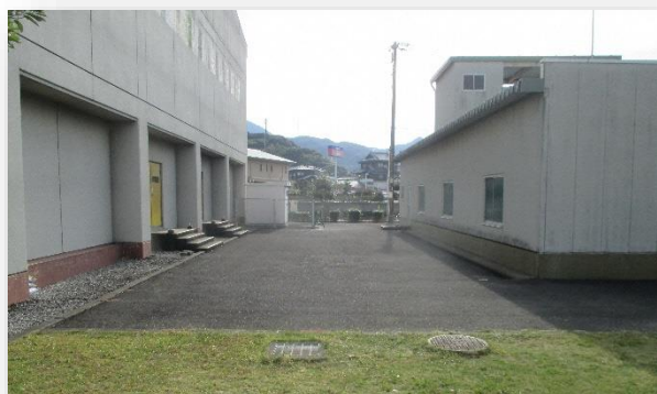
体育館と艇庫の間の多目的室建設予定地
