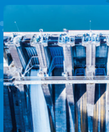
ダムなどの施設点検
