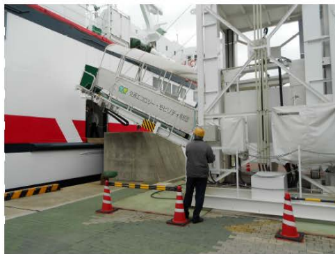
船側スロープ板を船舶の舷門に設置
