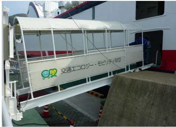
船側スロープ板と防衝工との間隔は数センチ
