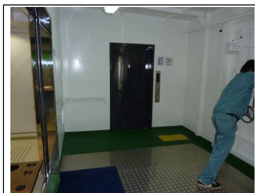
エレベーター
