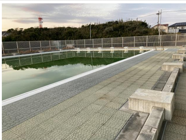
風害・塩害のため鉄骨撤去
