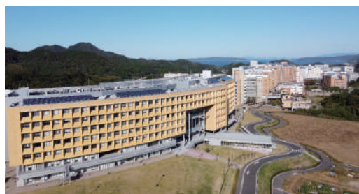
ウエスト5号館屋上の太陽光発電設備
