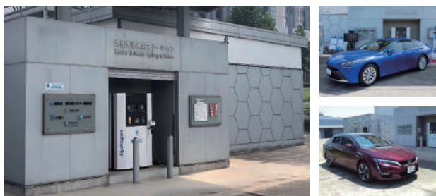
水素ステーション
