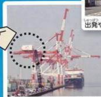
食料品や衣料品など生活必需品が たくさん詰まったコンテナを船に 積んだり降ろしたりする施設。 (ガントリークレーン)
