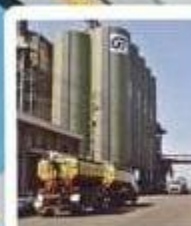
運ばれて来た 穀物は、サイロ という倉庫に 一旦、保管さ れる。
