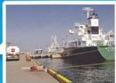
タンカーで運ばれて来た石油を パイプで陸のタンクに保存する。
