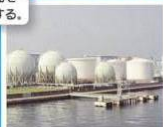
都市ガスを蓄えるガスホルダー LNG船が液化天然ガスを運ぶ。
