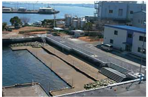
図2 7 横浜港の一角に完成した「潮彩の渚」
