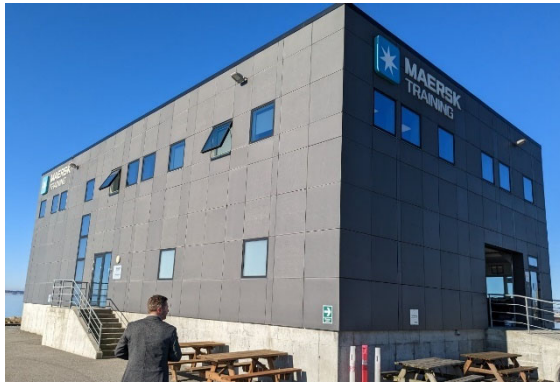
図 6 エスビエウ港の訓練施設外観
