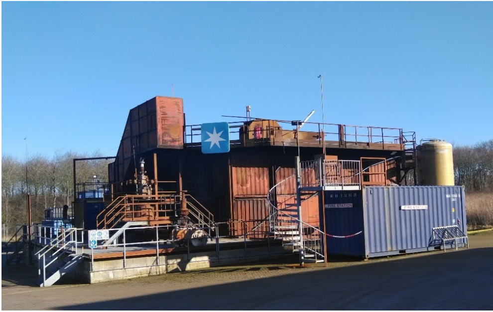
図 5 ガス油田における消火訓練施設
