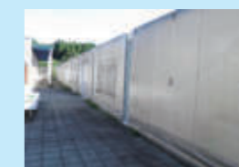
プール通路 (改修前)
