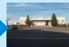
上屋シートセンター全体改修後
