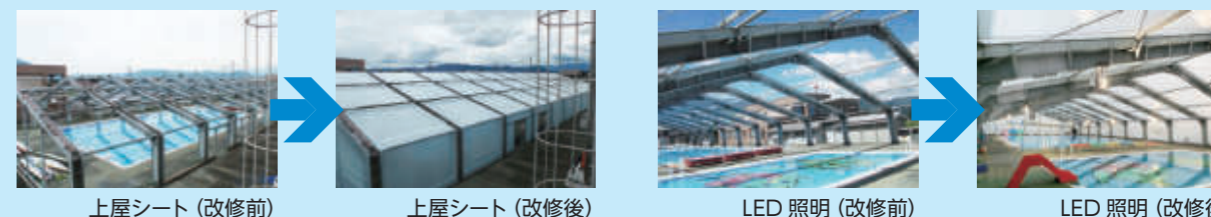
上屋シート (改修前)
