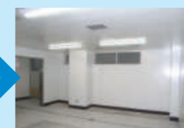
ロッカールーム (改修後)
