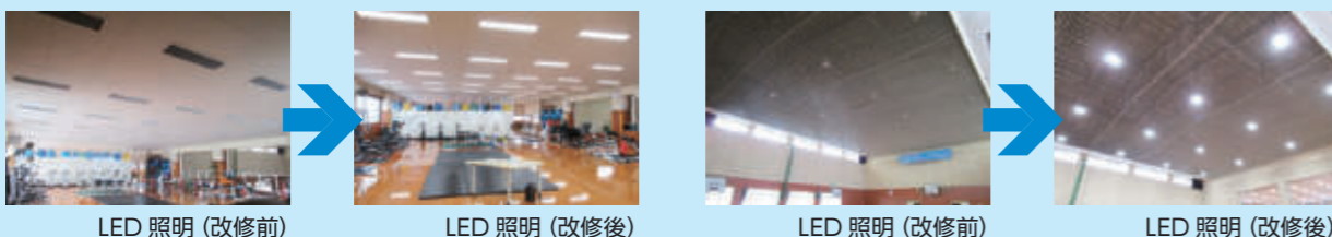
LED 照明 (改修前)
