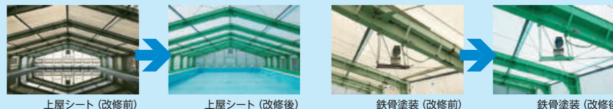
上屋シート (改修前)
