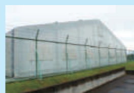
上屋シート (改修前)
