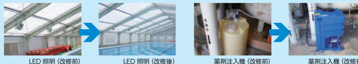
LED 照明 (改修前)
