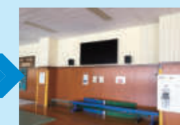
モニター設置 (改修後)
