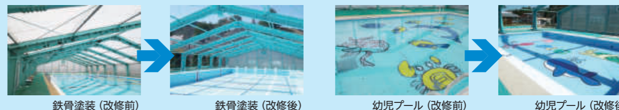
鉄骨塗装 (改修前)
