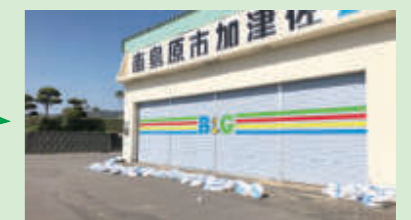
シャッター (改修後)
