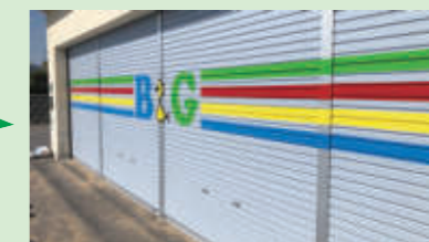
シャッター (改修後)
