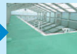
プール (改修後)
