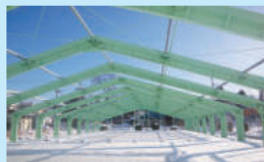
プール (改修後)
