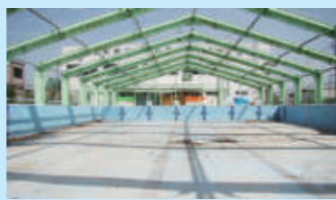
プール (改修前)
