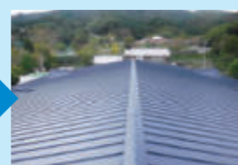
体育館屋根 (改修後)
