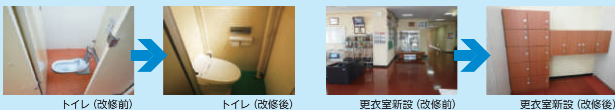
トイレ (改修前)
