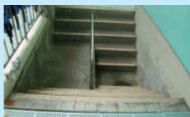
プール消毒槽埋め戻し (改修前)
