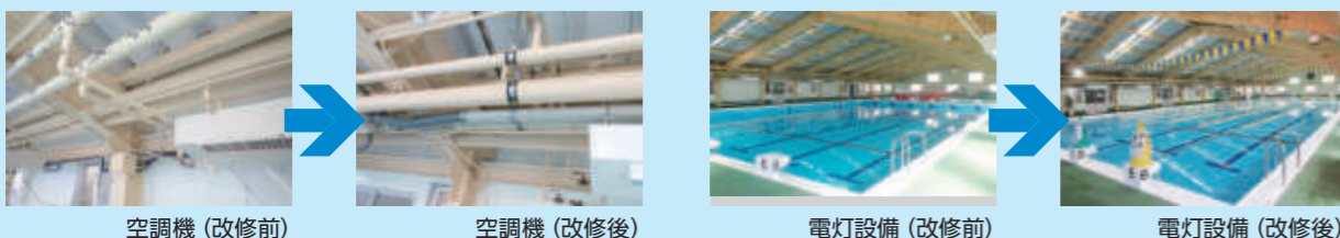
空調機 (改修前)
