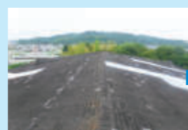
体育館屋根 (改修前)
