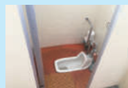
女子トイレ (改修前)
