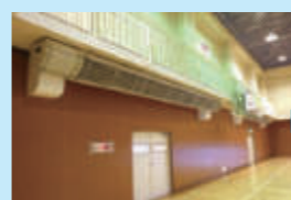
アリーナ暖房 (改修前)
