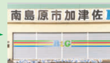
シャッター (改修後)
