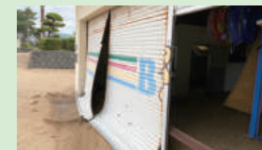
シャッター (改修前)
