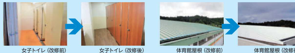
女子トイレ (改修前)
