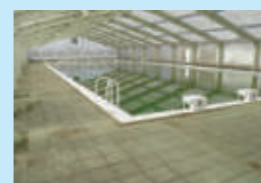
プール (改修前)
