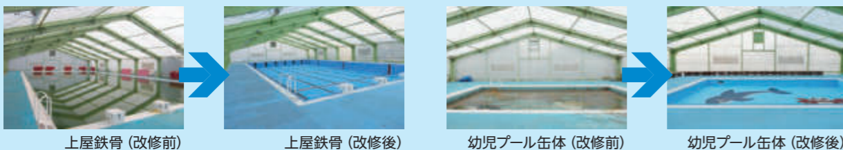
上屋鉄骨 (改修前)
