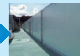
プール通路 (改修後)
