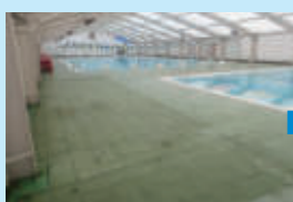
プールサイド (改修前)
