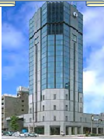
なとり本社ビル
