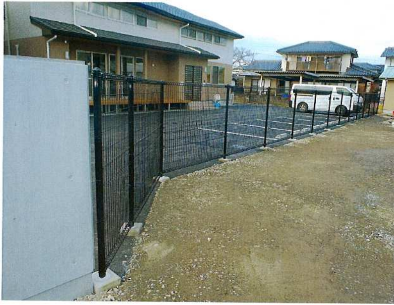
フェンス (東側)
