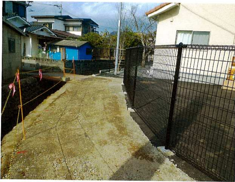
フェンス (南側)
