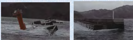
被災後の防波堤(北堤堤頭部から) 残存している南堤(堤頭部港内側から)
