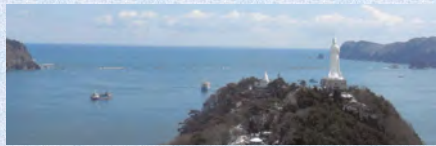
被災後の防波堤(全景, 3月17日撮影)
