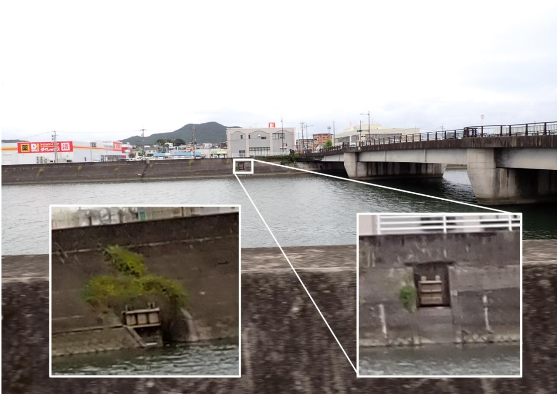
写真-3.7 花渡川への側溝からの流入口（右岸側、花渡橋上流側、2022年7月29日17時40分）
