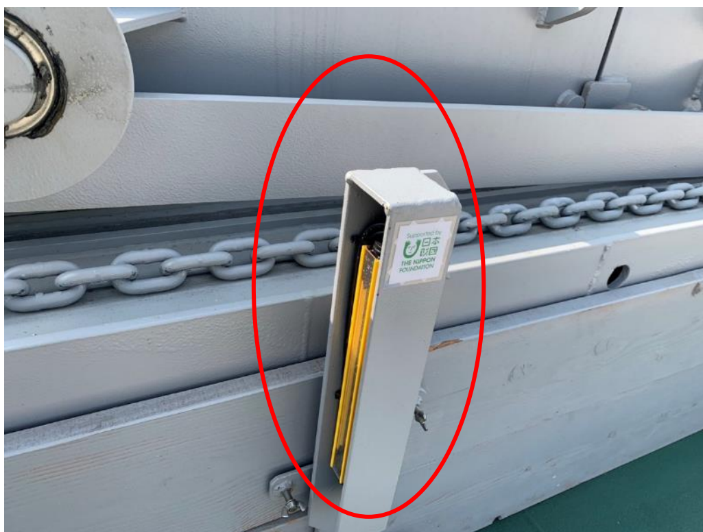
図32. エリアセンサー設置の様子
