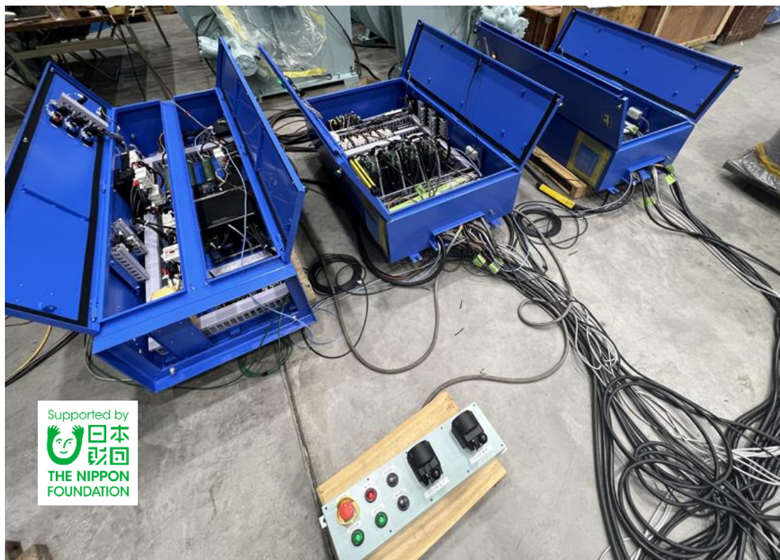
図15. 制御盤仮配線
