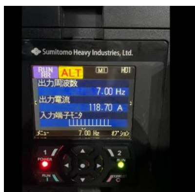
図23. 突入電流の測定
