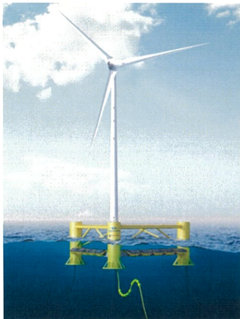
図-7 Bombora Wave Powerの風力/波力統合システムのコンセプト(InSPIRE18)
