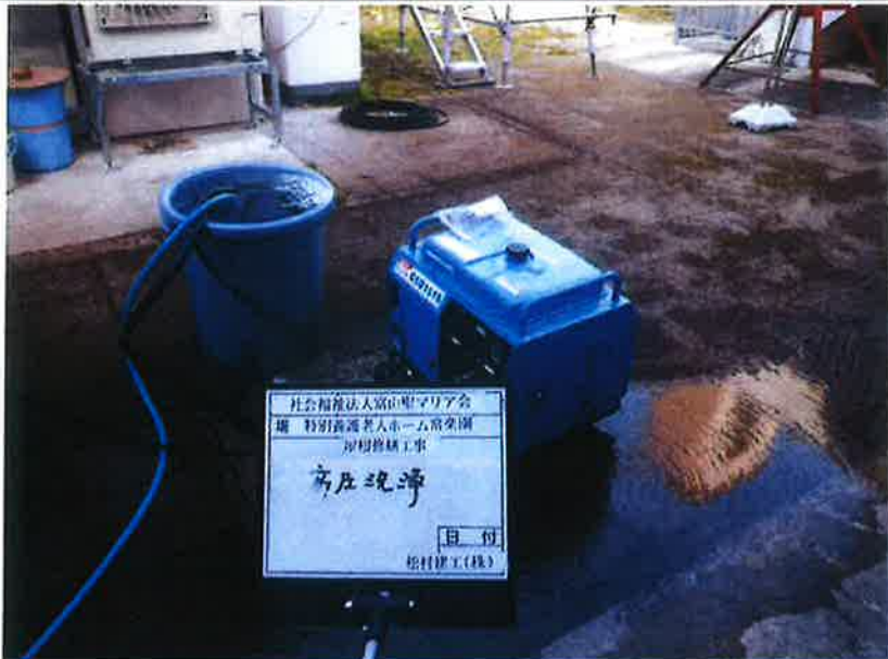
撮影項目 高圧洗浄
