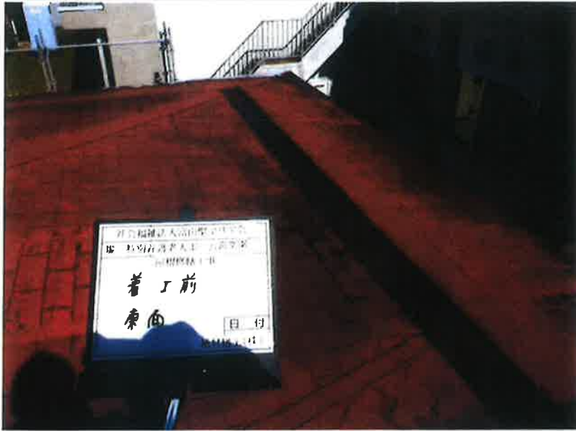
撮影項目 着工前 東面
