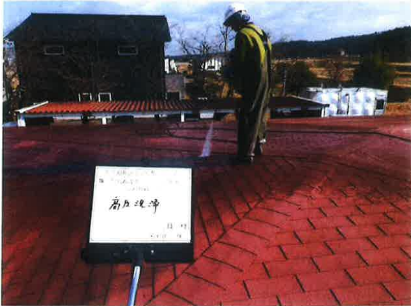
撮影項目 高圧洗浄
