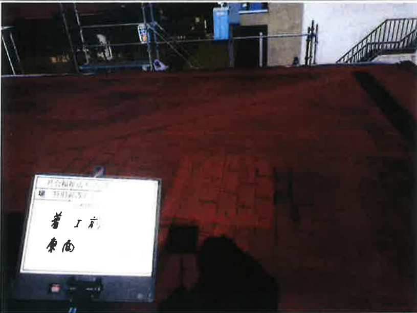
撮影項目 着工前 東面
