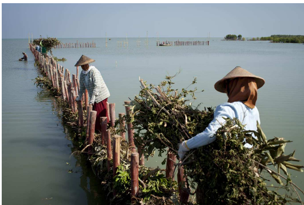
図 18 自然物によるフェンスを作っている様子。これによって堆積物をトラップし、干潟を作ることで海流散布されてきたマングローブの種子を捉え、自然な生態系の回復を目指す。UNFCCC の HP に掲載されていた報告書より転載。
