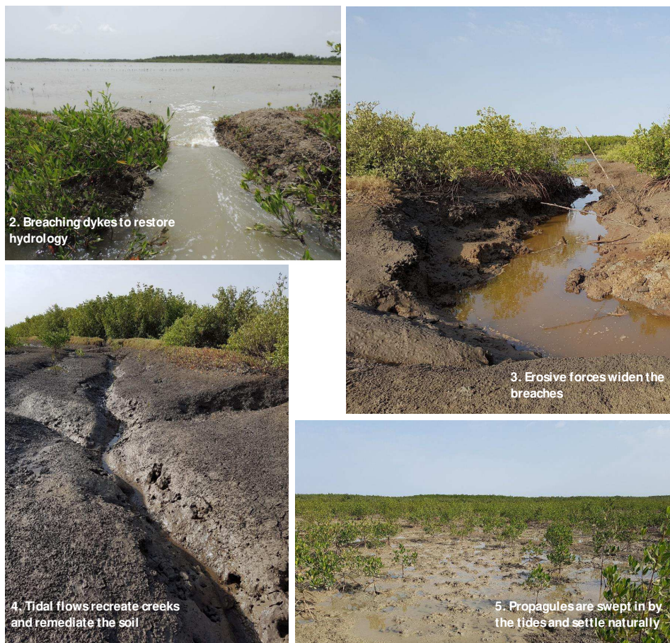
図 16 ギニアにおけるマングローブ林の再生を段階ごとに示した図。1.再生可能地域と対象範囲のプロット、2.水流を突り返すために土手を除去、3.水流によって水路が自然に拡大、4.潮汐によって入江が作られ、土マングローブに好適な土が再生、5.潮汐によって自然にマングローブの種子が流入し、生態系が回復
