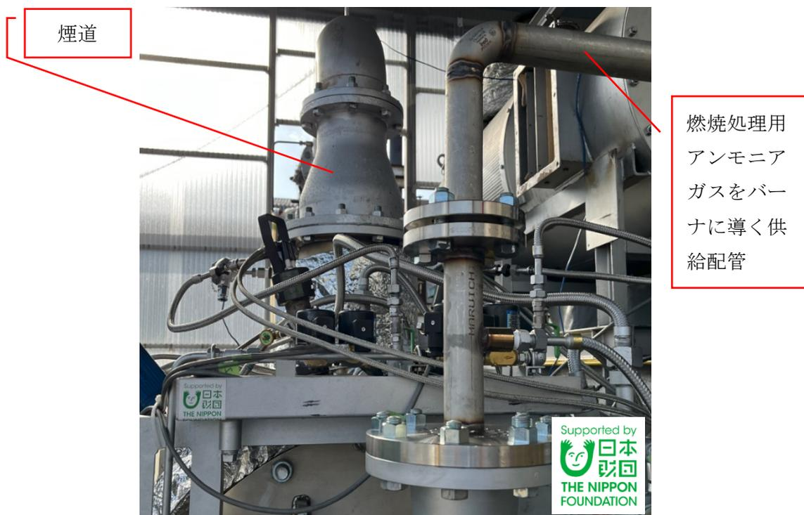
写真4 燃焼処理用アンモニアガスをバーナに導く供給配管
