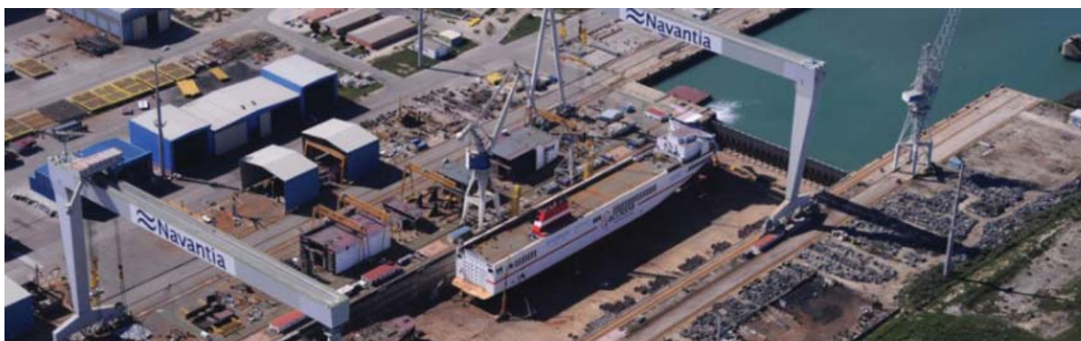
プエルトレアル造船所の乾ドック
