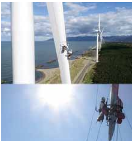
風力発電機ブレードの点検・検査・調査・補修
