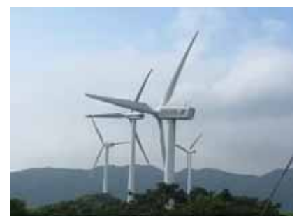
鹿児島県南さつま市の自社発電所(番屋風力発電所)
