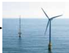
銚子沖着床式洋上風力発電
