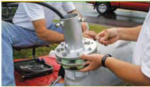
風力タービンを設置する様子
