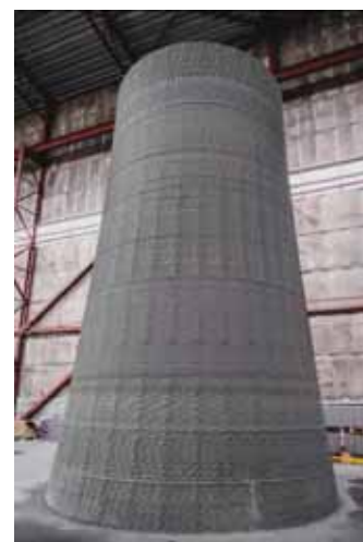
3Dプリント コンクリート基礎
