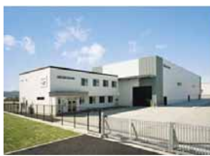
トレーニング施設を併設した北九州支店
