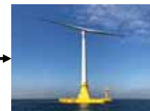
バージ型浮体式洋上風力発電システム実証機「ひびき」
