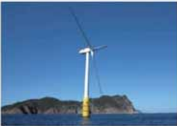
(支持構造物・洋上送電研究部門)
