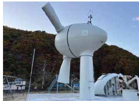
実機風車模擬訓練設備(エネルコン E40 及びGE 1.5S)
