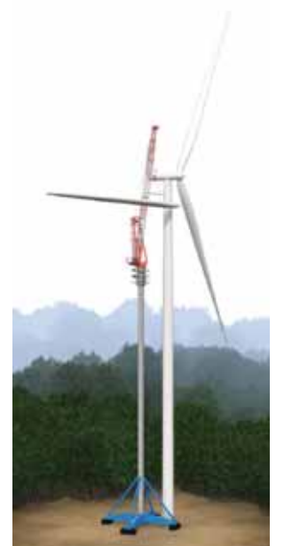
陸上風力発電施設建設中 (出典: 清水建設提供)
