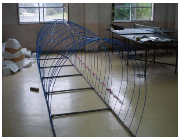
写真18 頭部より尾部を見る、高さ約1m
