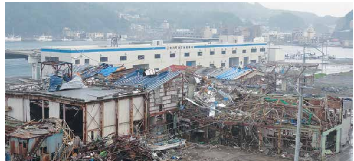
被災した工場
