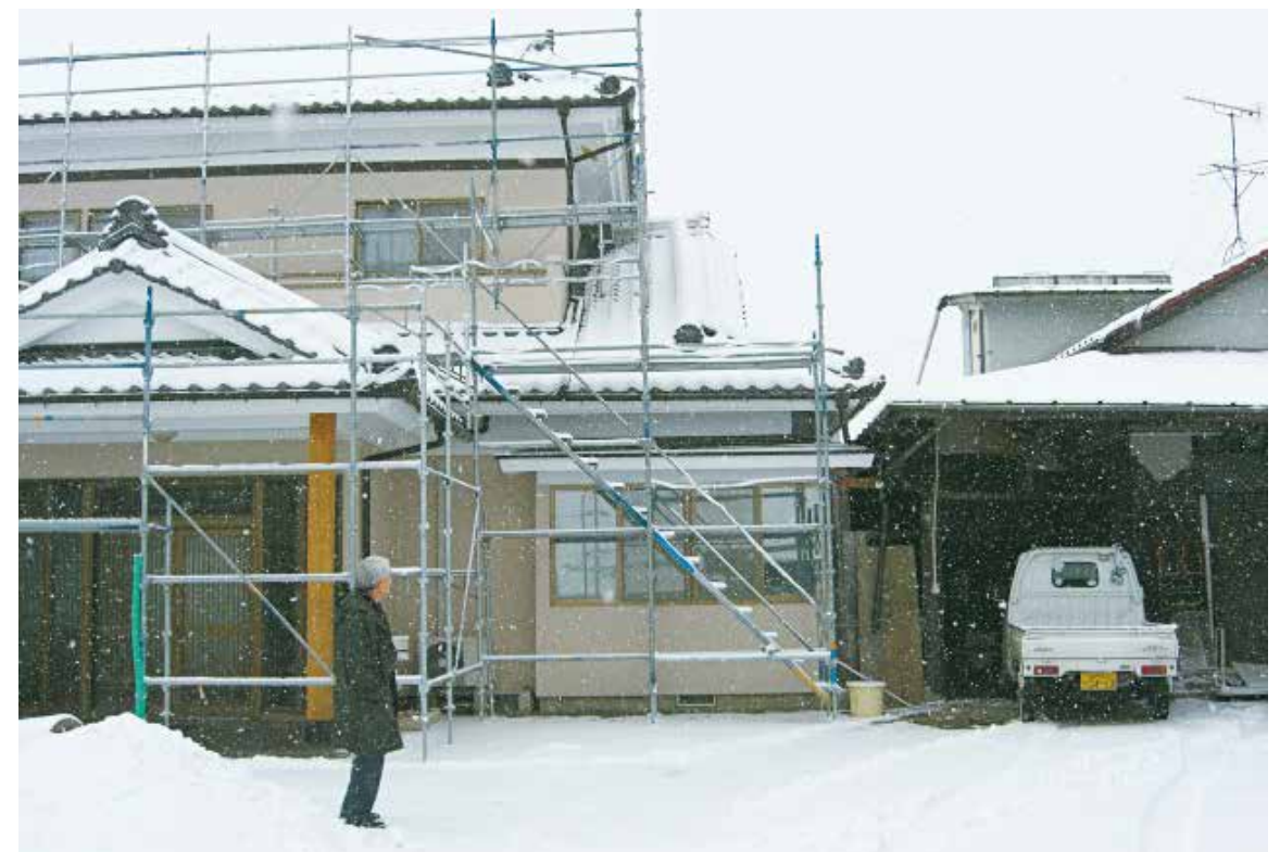
右側の作業小屋の屋根に浮かんでいた女性を救助した
