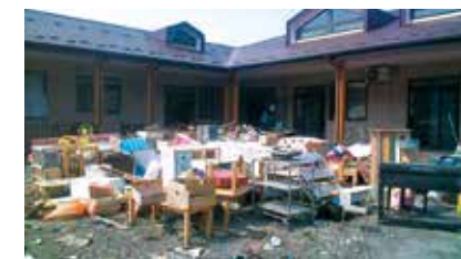
津波を受けた園舎
