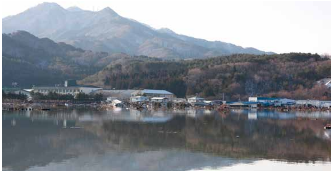
避難した赤前小学校 (左 窓が並んでいる建物)
