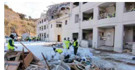
片付け作業中
