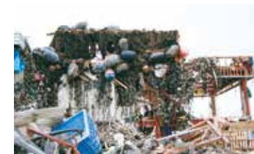
壊滅的な被害
