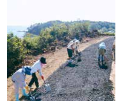
未来道建設仕上げ
