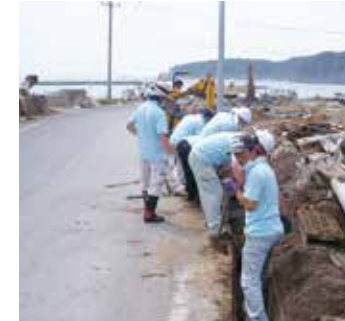
道路側溝清掃
