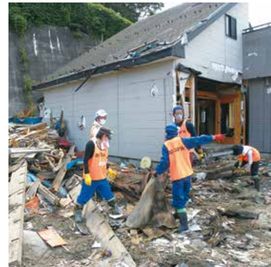
瓦礫の撤去作業
