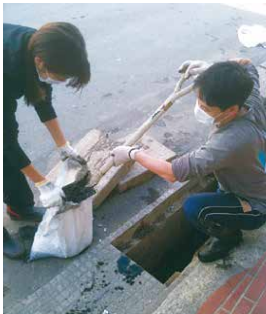
側溝のヘド口除去作業
