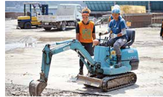
重機を使って作業中
