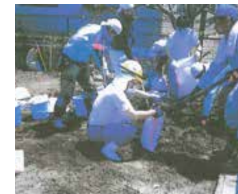
石巻市市街地 溜った砂礫を土のうに詰める
