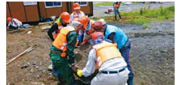
七ヶ浜町で瓦礫撤去
