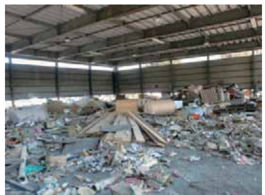
図1 1 6 仙台の被災倉庫
