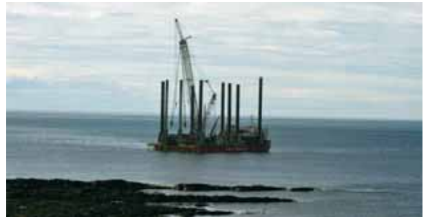
波力発電装置設置のための台船 （出典：アクアマリン・パワー社）
