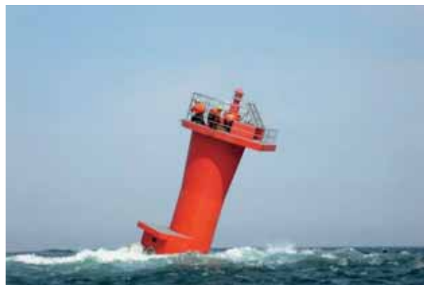
図1 2 13 震災により傾斜した灯台
