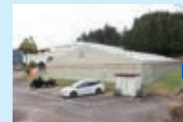
プール膜体 (改修前)
