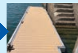
浮桟橋 (改修後)
