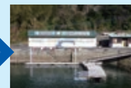
浮桟橋全体 (改修後)
