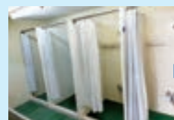
シャワー室 (改修前)
