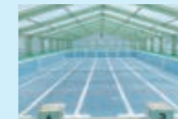
上屋鉄骨塗装 (改修前)
