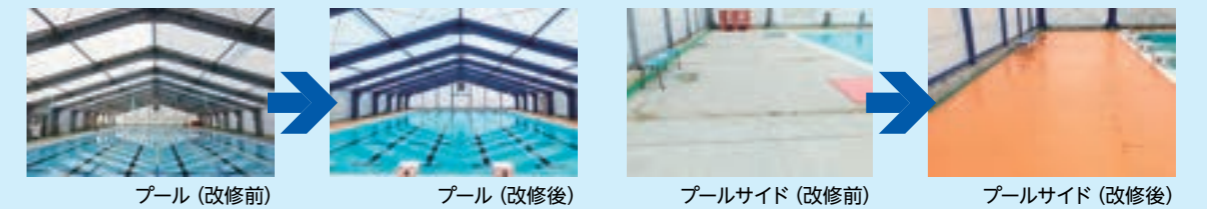
プール (改修前)
