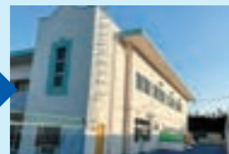
外壁塗装 (改修後)
