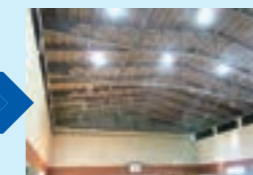
吊り天井撤去 (改修後)
