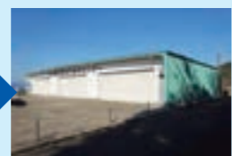
外壁・シャッター (改修後)
