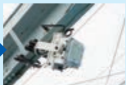
LED 照明 (改修後)
