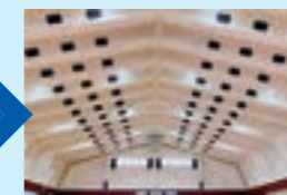
アリーナ照明 LED 化(改修後)
