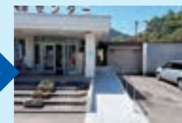
玄関スロープ (改修後)
