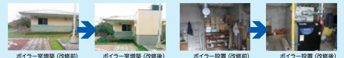
ボイラー室増築(改修前) ボイラー室増築(改修後) ボイラー設置(改修前) ボイラー設置(改修後)
