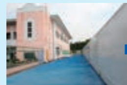
外壁塗装 (改修前)
