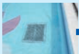
排水溝回り (改修前)
