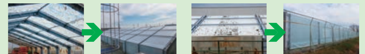
プール上屋 (改修前) プール上屋 (改修後) プール側面 (改修前) プール側面 (改修後)
