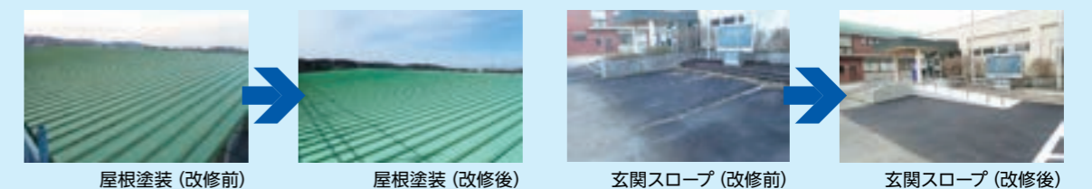
屋根塗装 (改修前)
