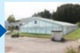
プール膜体 (改修後)
