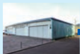
外壁・シャッター (改修前)
