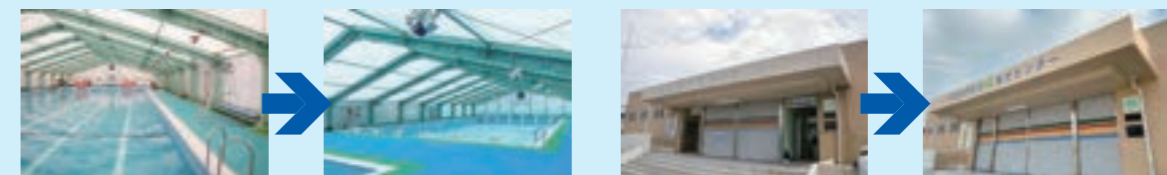
上屋シート・プールサイド (改修前) 上屋シート・プールサイド (改修後) 外壁・サイン (改修前) 外壁・サイン (改修後)
