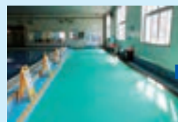
プールサイド (改修前)
