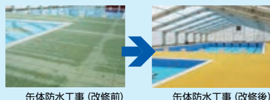
缶体防水工事(改修前) 缶体防水工事(改修後)
