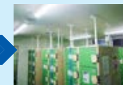
倒壊防止固定 (改修後)
