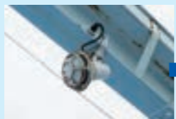
LED 照明 (改修前)
