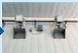
プール LED 照明 (改修後)
