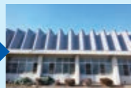
屋根改修 (改修後)
