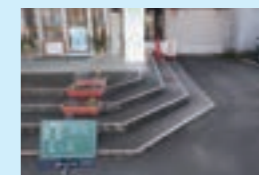
玄関スロープ (改修前)
