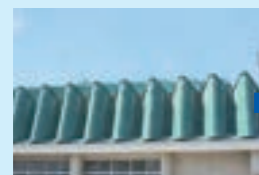
屋根改修 (改修前)
