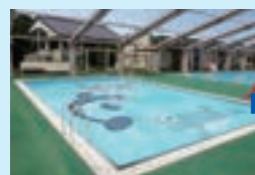
幼児用プール (改修前)
