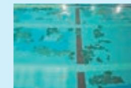
プール (改修前)
