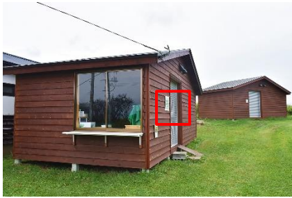
・既存倉庫への受付カウンターおよび窓設置
