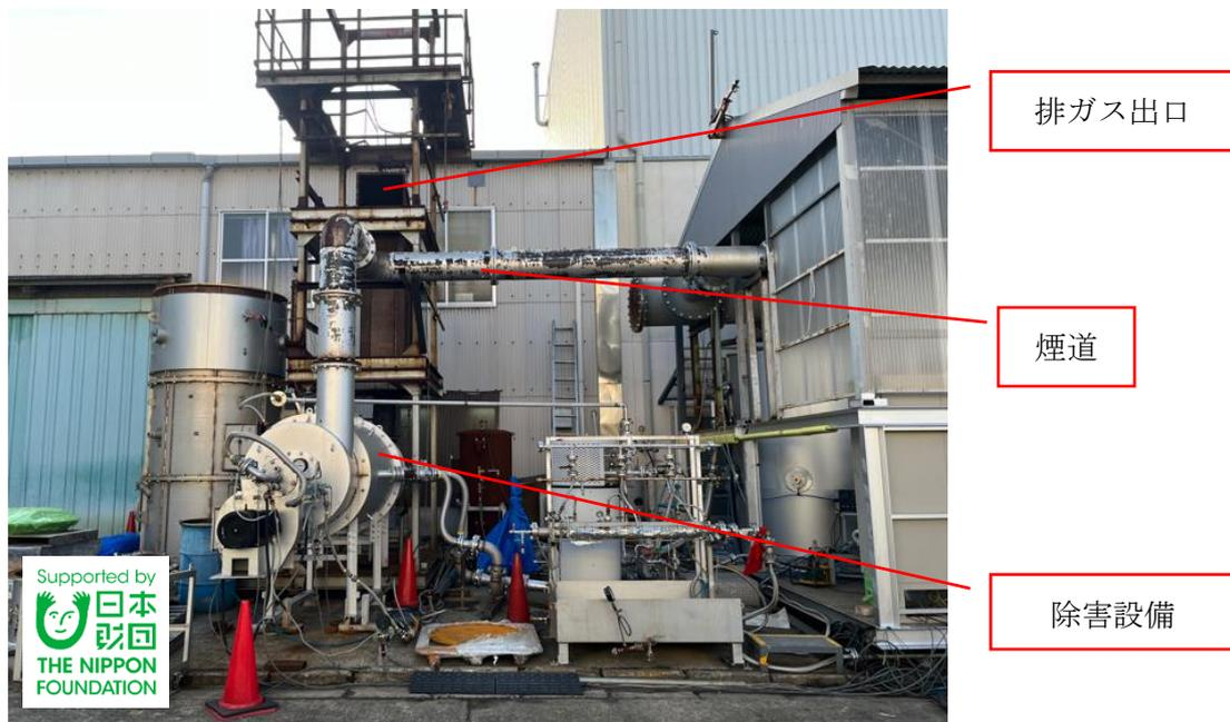
写真8 除害設備および排ガス出口（正面より）
