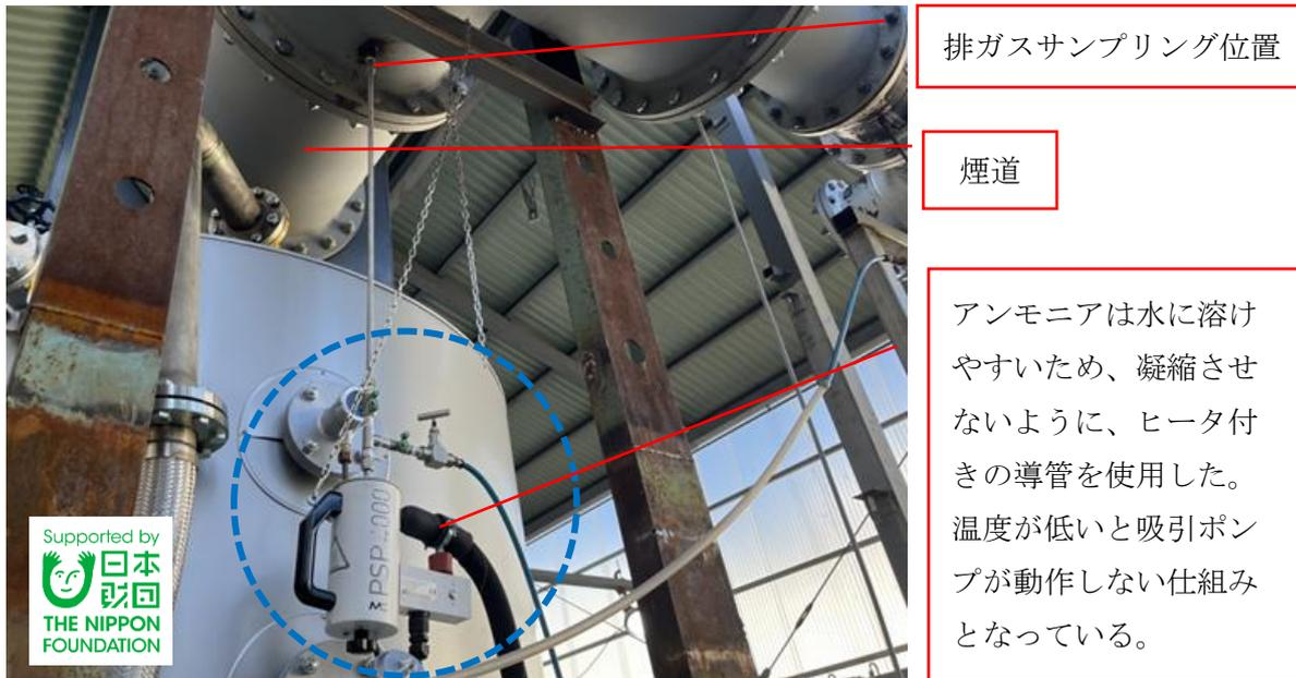
写真 5 煙道および排ガスサンプリング位置
