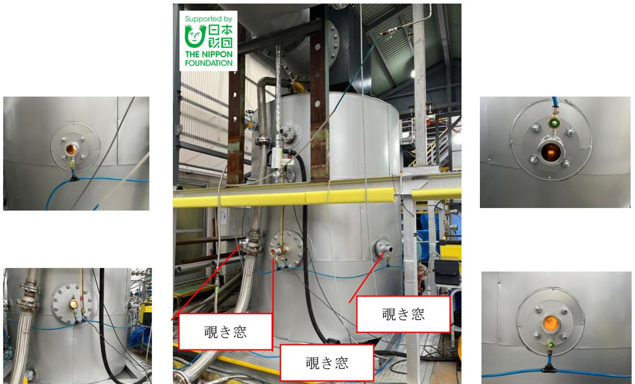
写真4 試験用ボイラ炉体に設けた覗き窓
