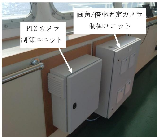
図 45 カメラシステム制御ユニット装備状況（ブリッジ左舷側）
