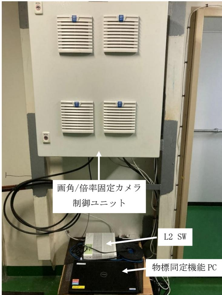
図 68 カメラシステム制御ユニット及び物標同定機能 PC 装備状況
