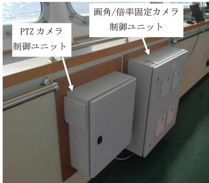
図 26 カメラシステム制御ユニット装備状況（ブリッジ左舷側）
