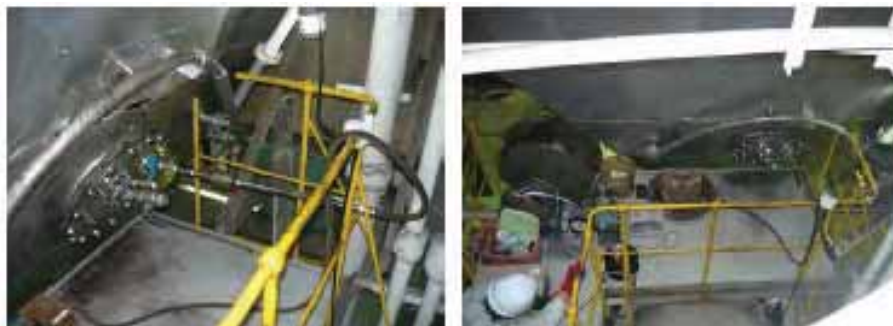
図 2.3-4 アンダーセンスタックサンプラによるサンプリング
