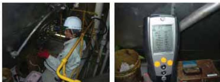
図 2.3-8 燃焼排ガス分析計によるガス状物質及び排ガス温度の測定風景
