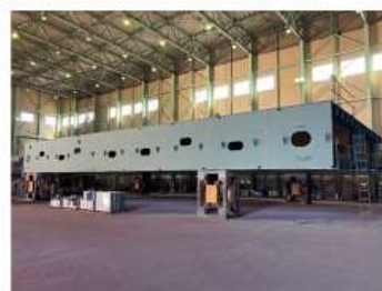
2重底ブロック外観
