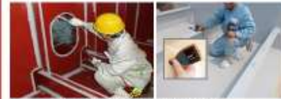
手作業による刷毛塗り（左）と塗膜厚の計測（右）
