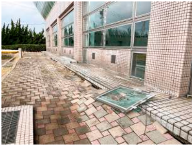
石川県志賀町富来海洋センター プール
