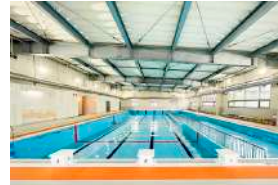
上屋付きプール屋内温水化 (北海道大樹町)
