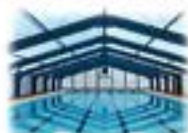
上屋シート取替・鉄骨塗装
