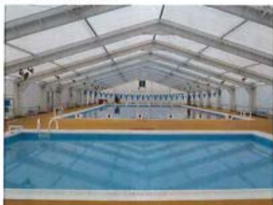
プール (改修前)
