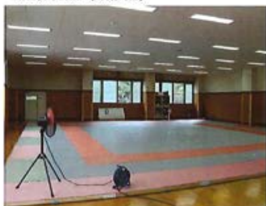
2階体育館（改修前）
