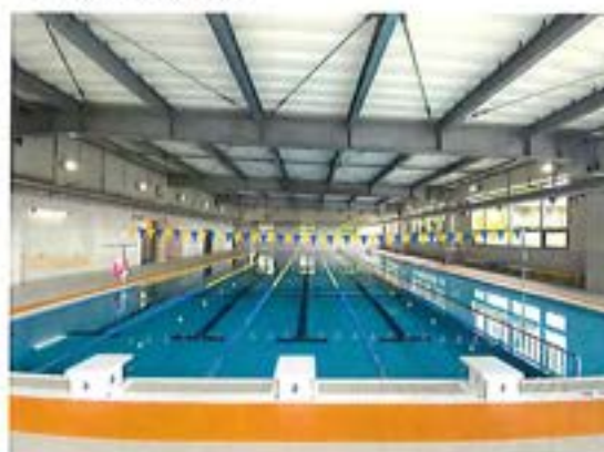
プール (改修後)
