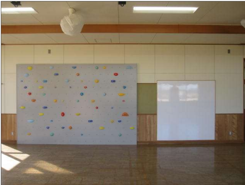
令和5年西外城田内部・外壁 改修工事 完成 プレイルーム
