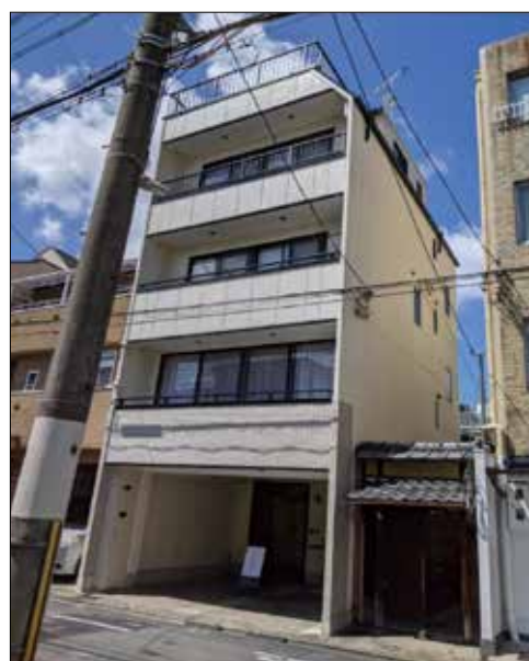
シェアハウス 「せせらぎ中京分室」(4部屋)
