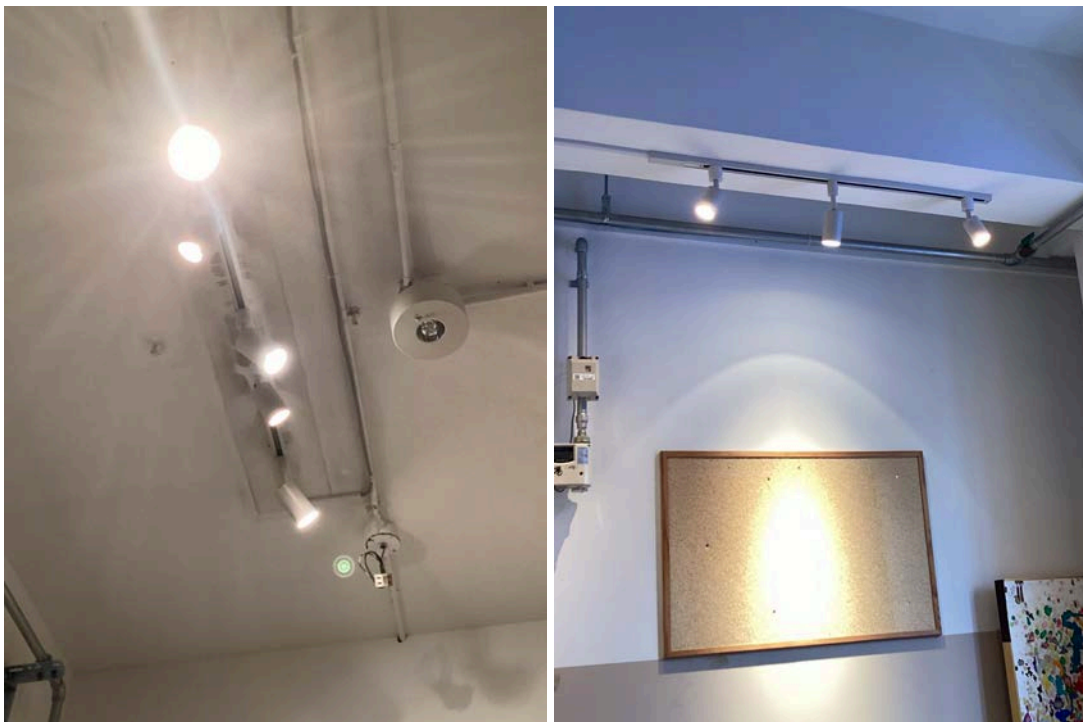
工事第15号 3階学習室電気工事
